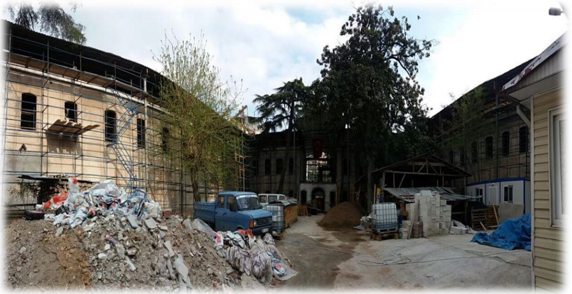
Resim 11. Askeri Hastane Binası İnşaatı Dış Görsele
