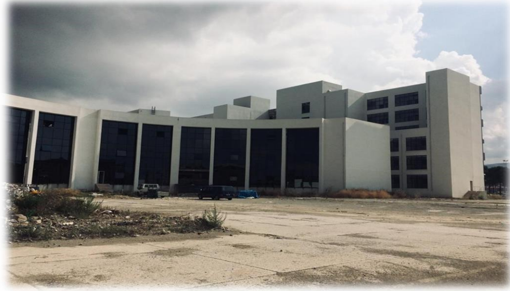
Resim 2. Mühendislik ve Mimarlık Fakültesi İnşaatı Görseli
