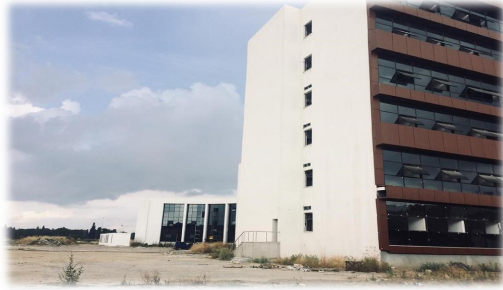
Resim 3. Mühendislik ve Mimarlık Fakültesi İnşaatı Görseli
