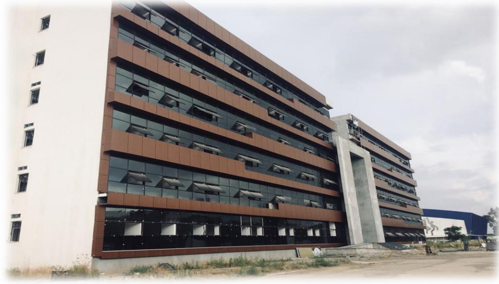
Resim 1. Mühendislik ve Mimarlık Fakültesi İnşaatı Görseli
