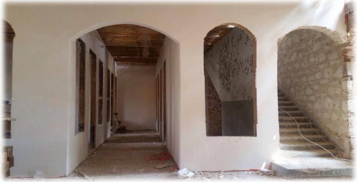
Resim 10. Askeri Hastane Binası İç Görünüm
